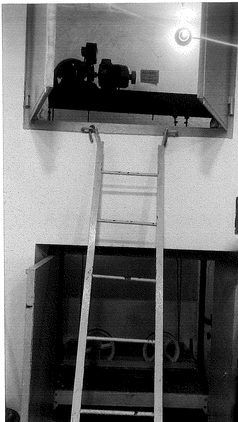
Zdjęcie 4: Widok usytuowania maszynowni
