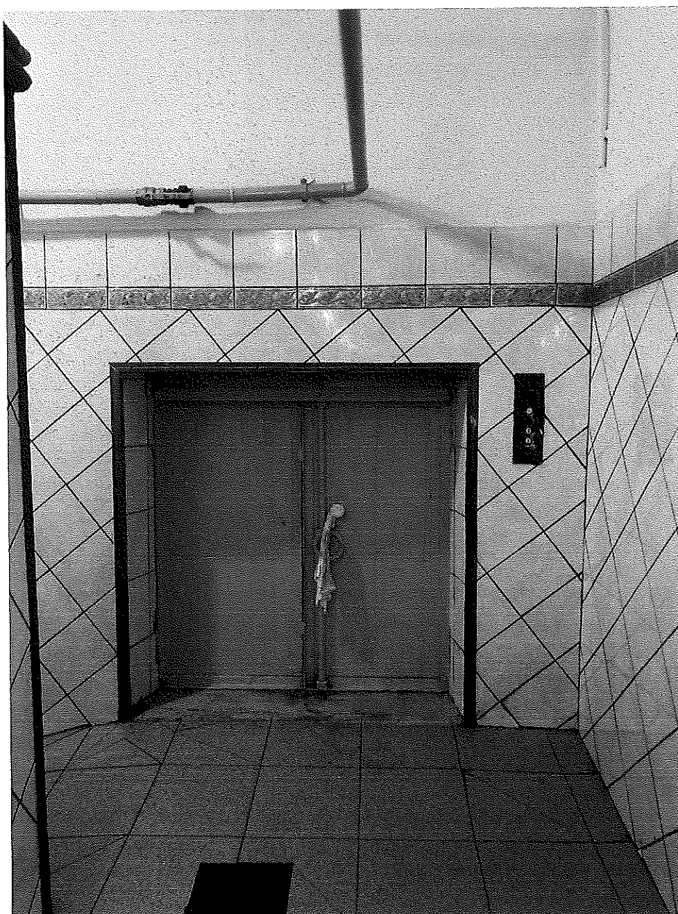
Zdjęcie 1: Widok drzwi dźwigu: POZIOM -1
