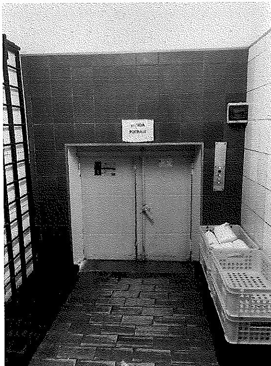
Zdjęcie 3: Widok drzwi dźwigu: POZIOM 1 oraz drzwi do maszynowni
